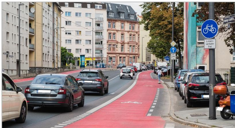
Abbildung 9: Sicherheitstrennstreifen zum ruhenden Kfz-Verkehr an Radfahrstreifen (Beispiel Frankfurt am Main, eigenes Bild)
